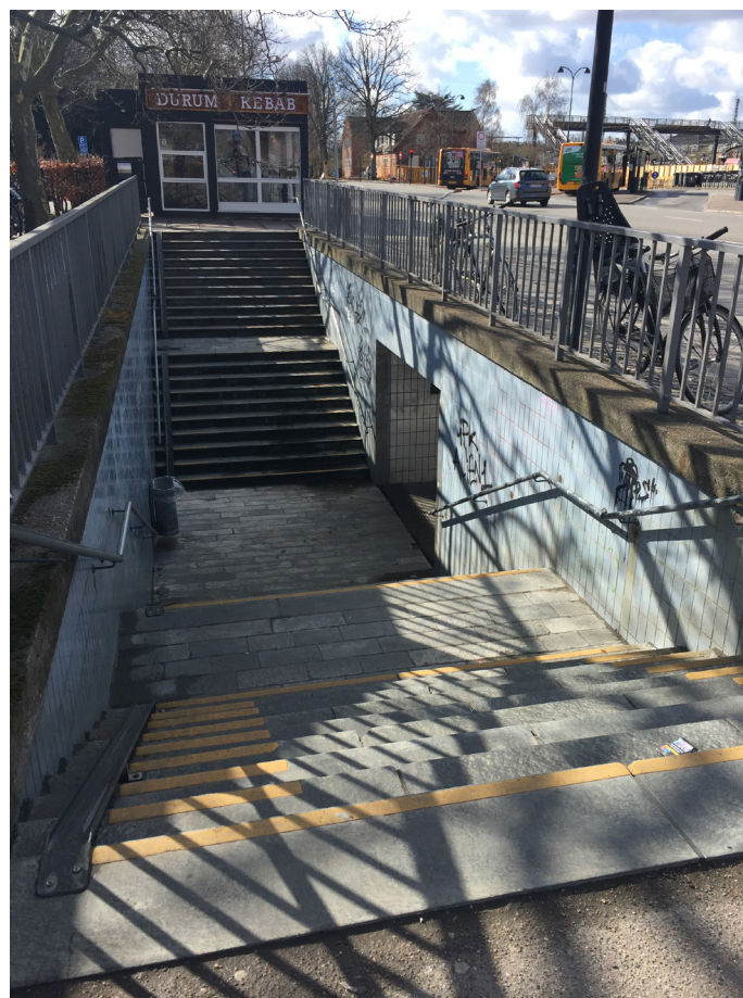
Trapper skal som minimum udstyres med slidsker, så cyklen nemmere kan transporteres op og ned - og gerne i begge sider.
