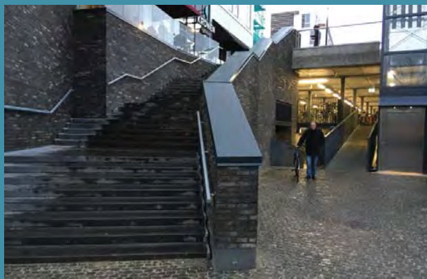
ADGANG TIL CYKELPARKEREN P-huset er svært at få øje på pga. placering og manglende skiltning. Derudover er der ingen indgang til selve bygningen endnu (dog under opførelse).
